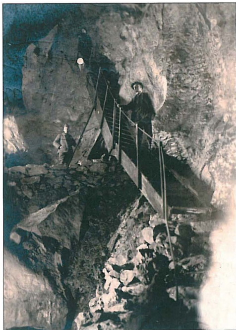
A Pál-völgyi-barlang Színház-termének lépcsője (Sz. K.) The staircase leading to the Theatre room of the Pál-völgy cave (Budapest)
